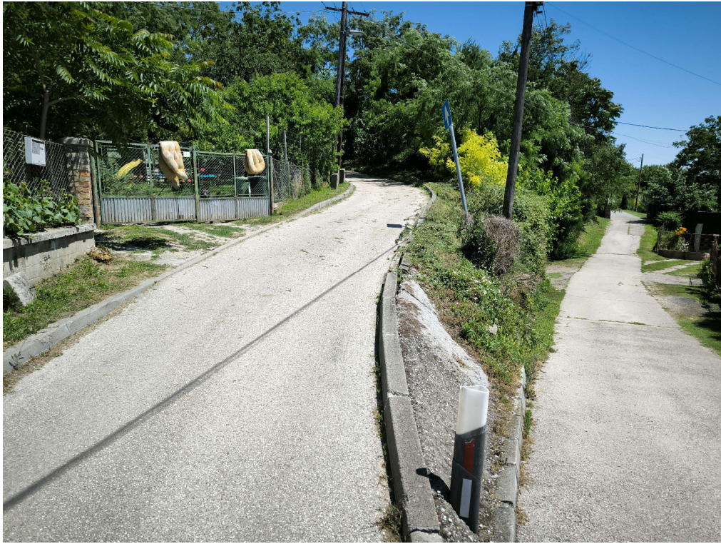
4. kép: A Dózsa Gy. utca két út- ága közötti partfal mozgása miatt a jelzőtábla és a telefon légvezeték oszlop is elbillent már. Az alsó út kiemelt szegélyét a lefolyt omladék szinte teljesen elfedi. A kép alján még látható a szegély, feljebb már az omladék miatt eltűnik.
