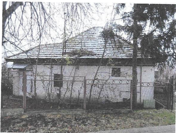
Az Ady Endre u. 19. számú épület lábazati részei feláztak.
