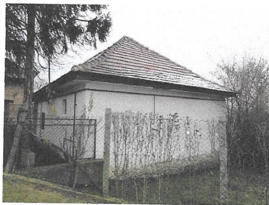
Az Ady Endre u. 19. számú épület lábazati részei feláztak.
